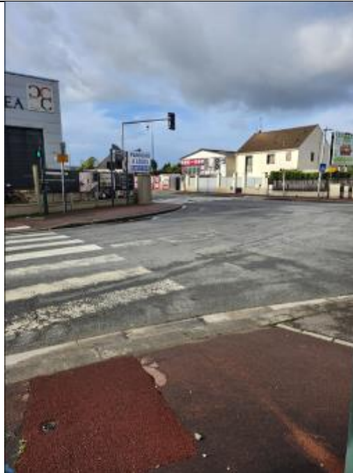
Fig. 18 : Passage protégé pour piétons prolongeant la piste longeant les Ets Dauphin
