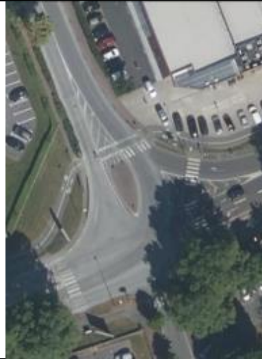
Fig. 26 : Intersection r. du Tir et rte de La Montagne
