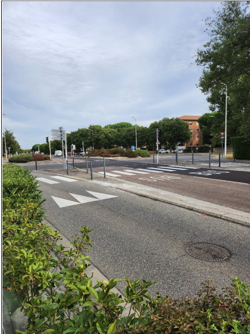
Figure 5 : exemple d'un giratoire avec voie centrale réservée aux bus
